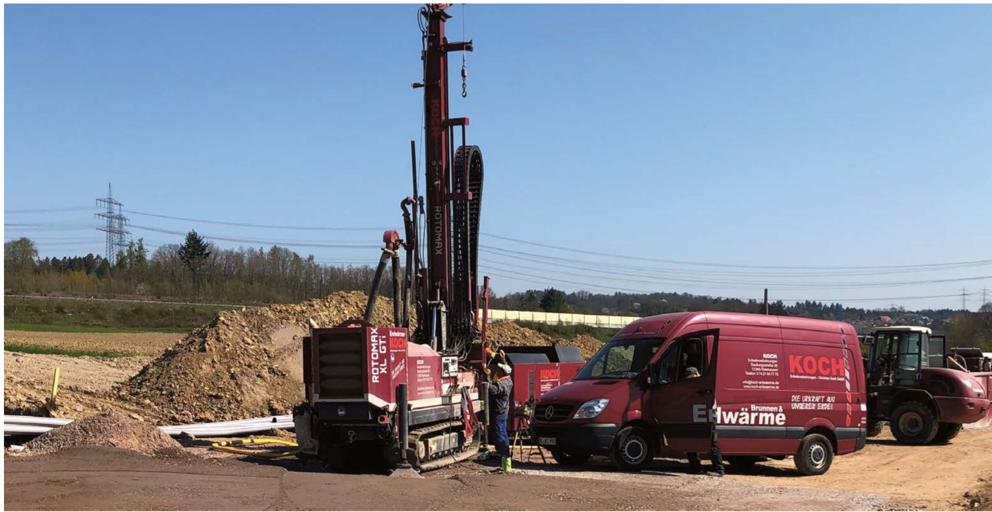
„Kalte Nahwärme“ aus bis zu 160 Meter Tiefe versorgt das Neubaugebiet „Auf Leim“ in Murg.
