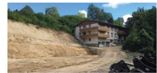
Bereit zum Refurbishment: Ein ehemaliges Bürogebäude ist komplett entkernt und wird zum Wohngebäude umgebaut.
